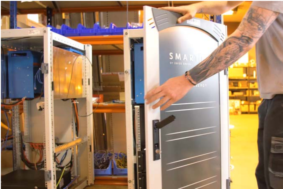
Assemblage dans nos ateliers
